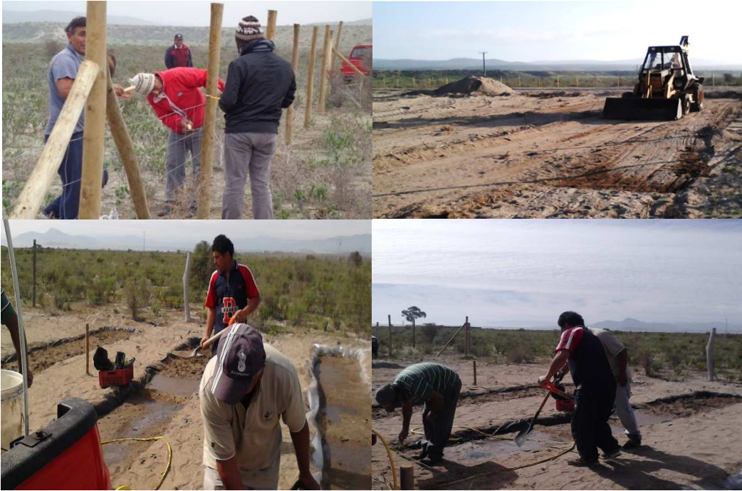
Fotografía N° 7: Actividades de Adecuación de terreno experimental, Puerto Aldea, Tongoy.
