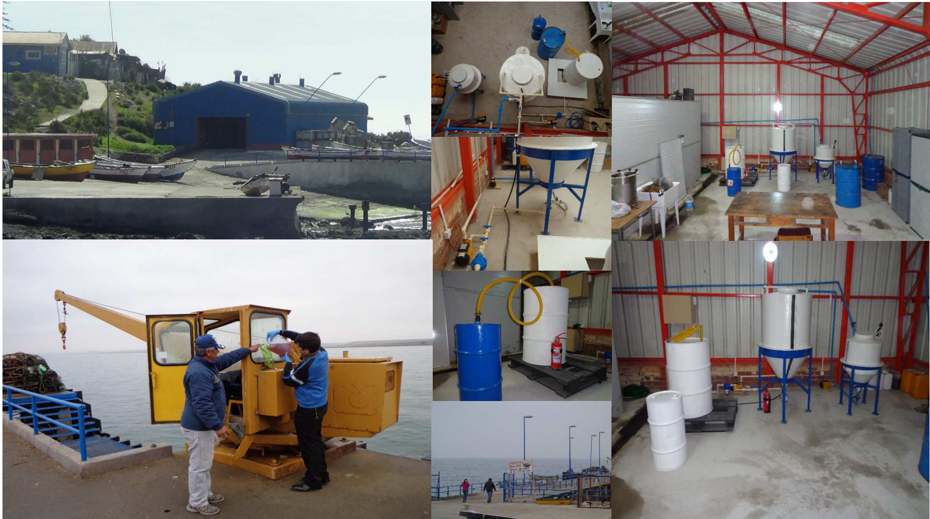
Fotografía N° 10: Construcción de planta piloto de producción de Biodiesel, Puerto Aldea, Tongoy.
