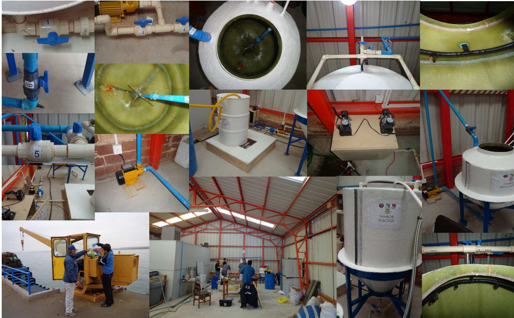
Fotografía N° 9: Construcción y ensamblaje de planta piloto de producción de biodiesel, Puerto Aldea, Tongoy.
